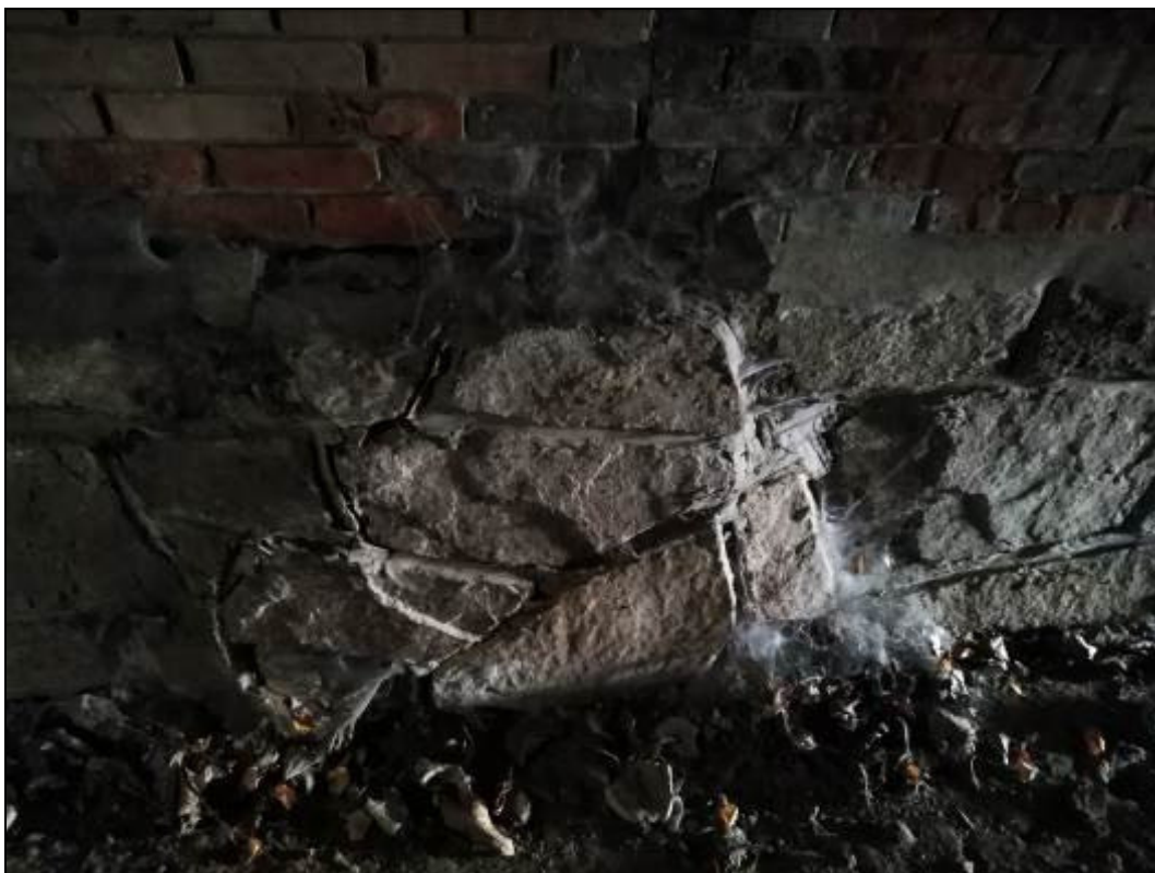
Obr. č. 13 - pohled na vytlačené kamenné zdivo spodní stavby
