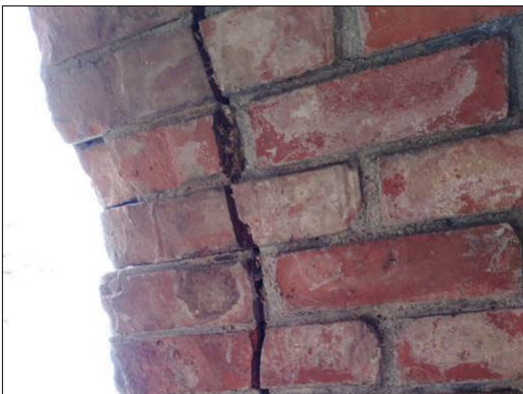
Obr. č. 12 - pohled na trhlinu v nosné konstrukci u levého čela
