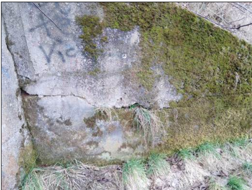
Obr. č. 11 - pohled na vodorovnou trhlinu křídla u pravého čela
